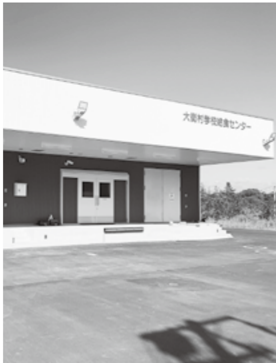
完成した新給食センター
