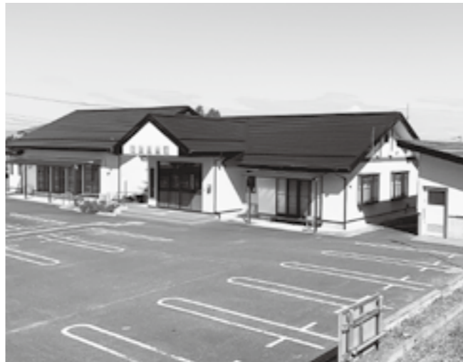
屋根塗装が行われた衛上集会所
