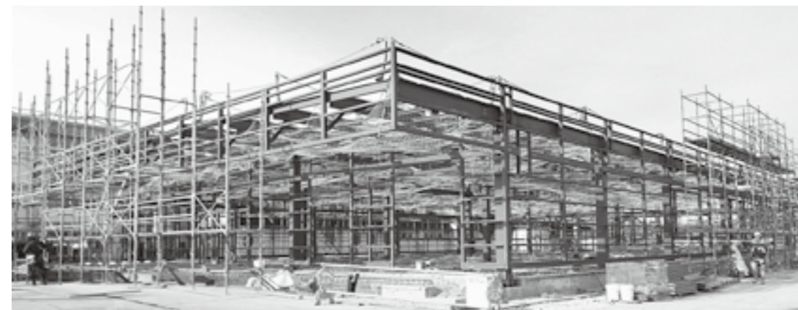
工事中の給食センター
