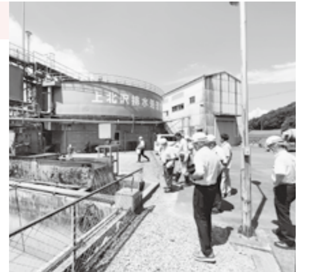
上北沢排水処理施設を調査
