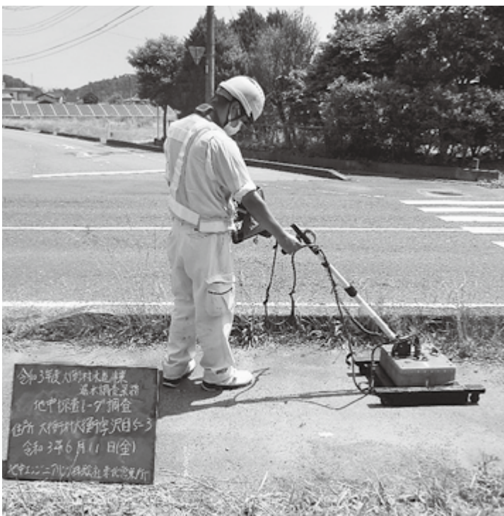
“わずかな音も逃がさない” 路面音聴調査
