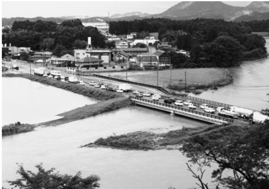
氾濫した善川・埋川合流地点（H27. 9. 11）
