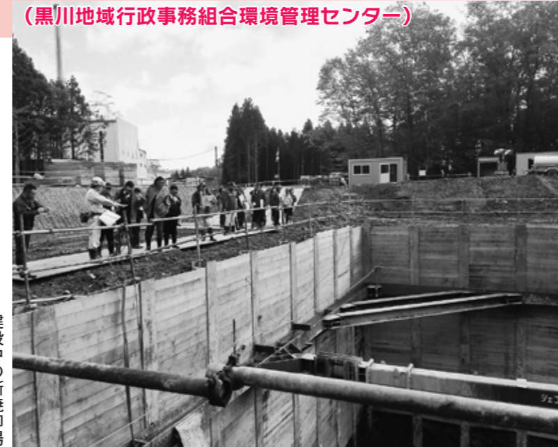
建設中の新焼却場
