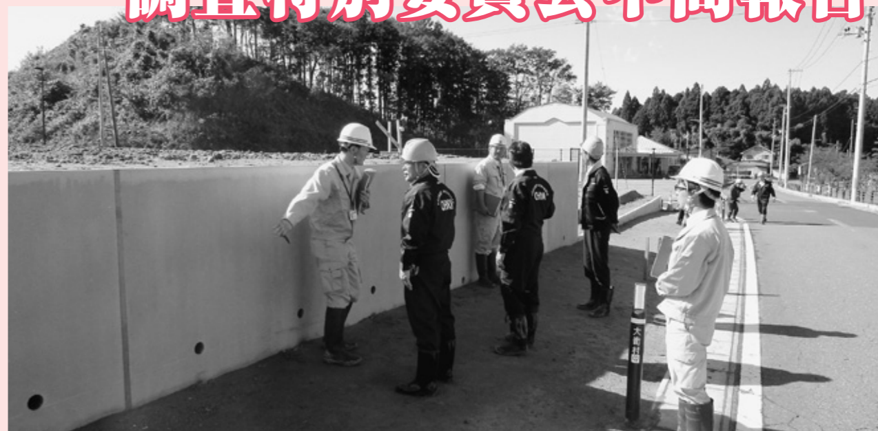
工事状況の現地調査
