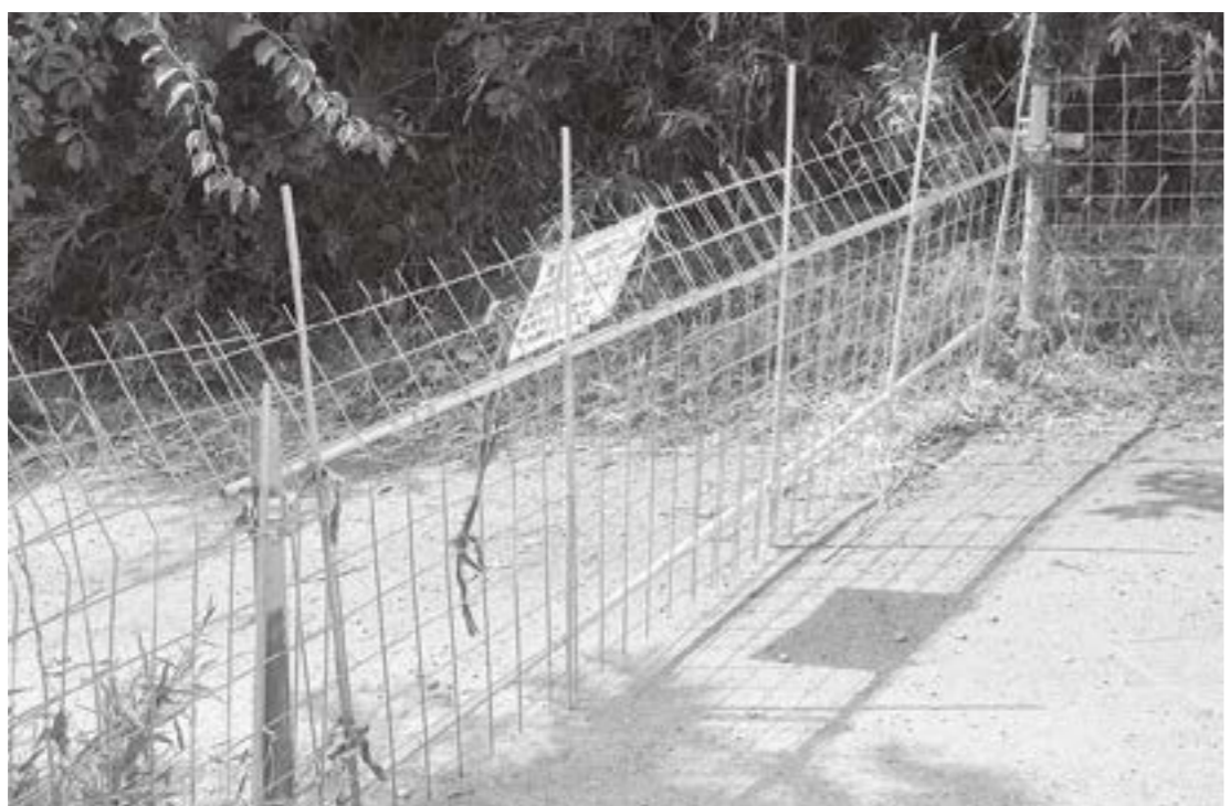
ワイヤーメッシュ防護柵設置状況
