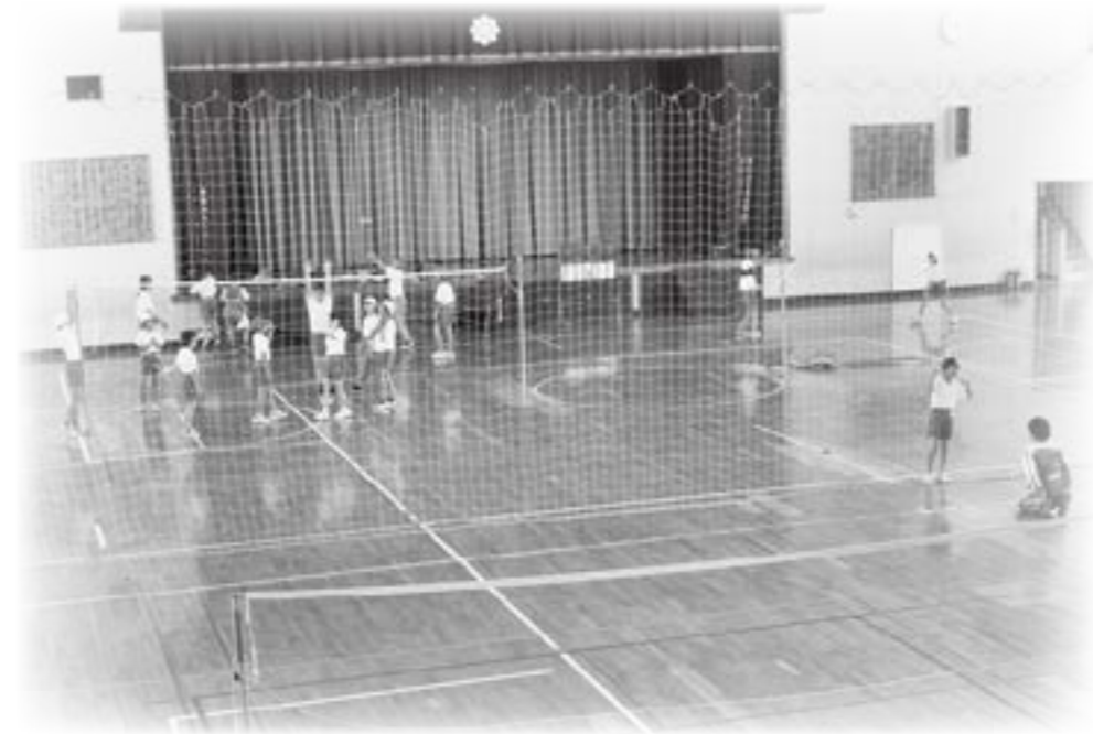
改修が待たれる小学校体育館
