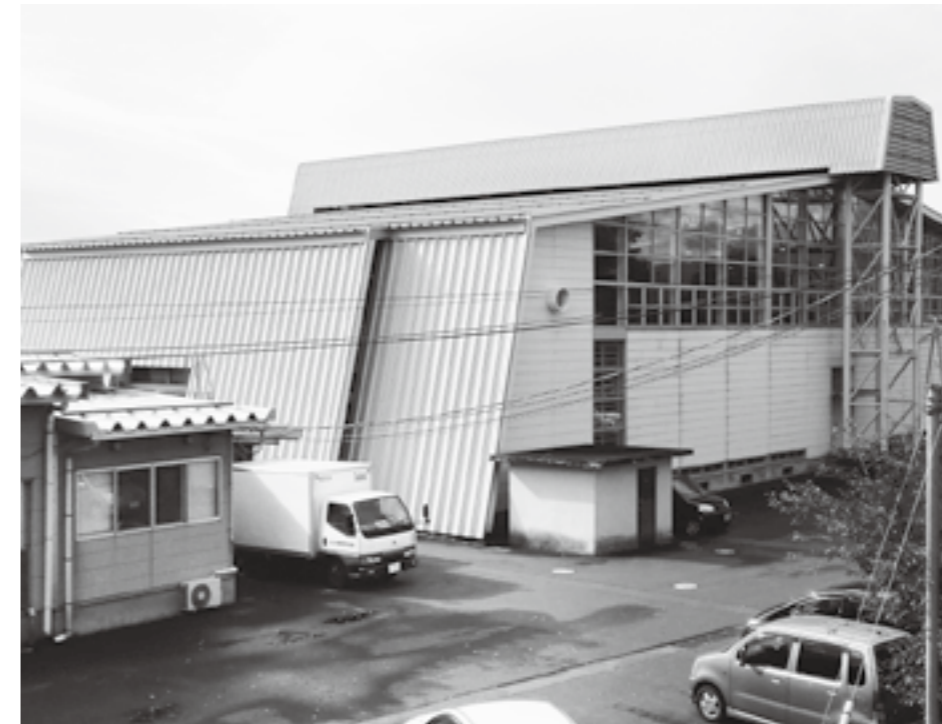
小学校体育館
