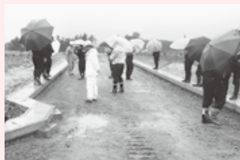
ときわ台南造成地現地調査
