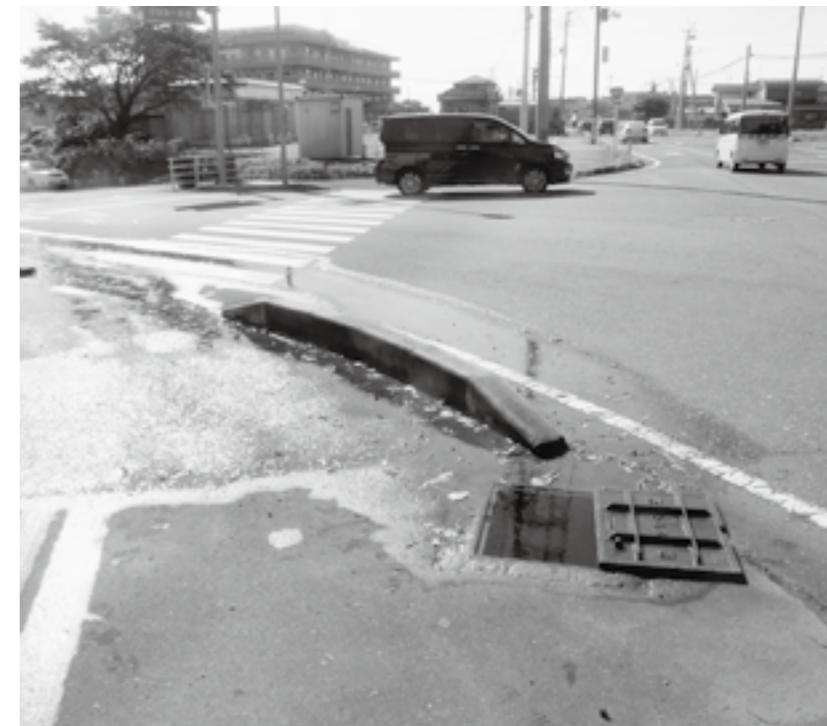
老朽化による水漏れ
