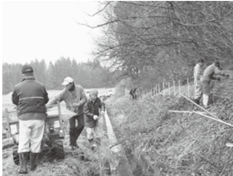
イノシシ防護柵設置作業
