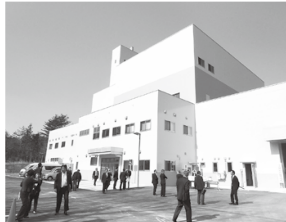
新築されたごみ焼却施設（黒川環境管理センター）
