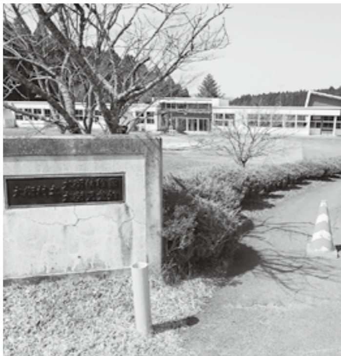
6年間使われていない旧幼稚園舎
