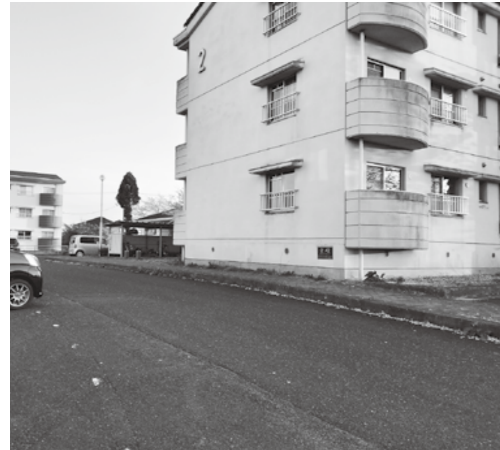
改修予定の五反田住宅
