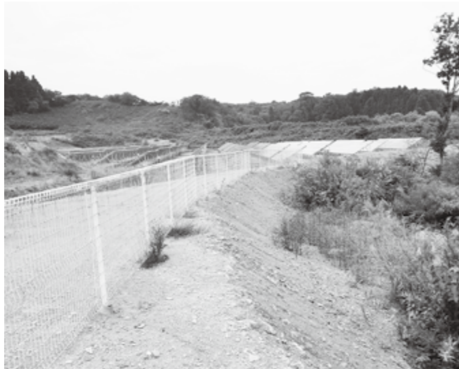
土砂流出が心配される太陽光発電施設
