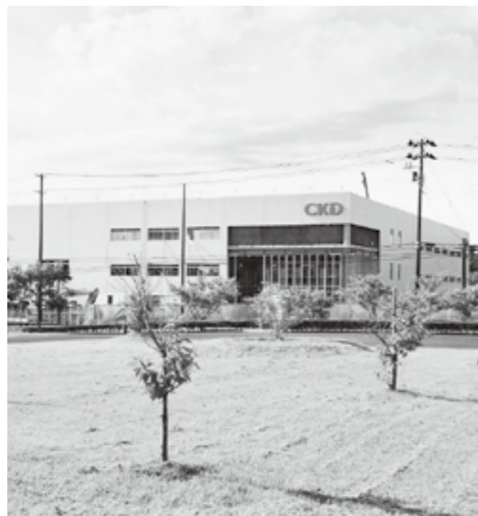
建設中の誘致企業工場
