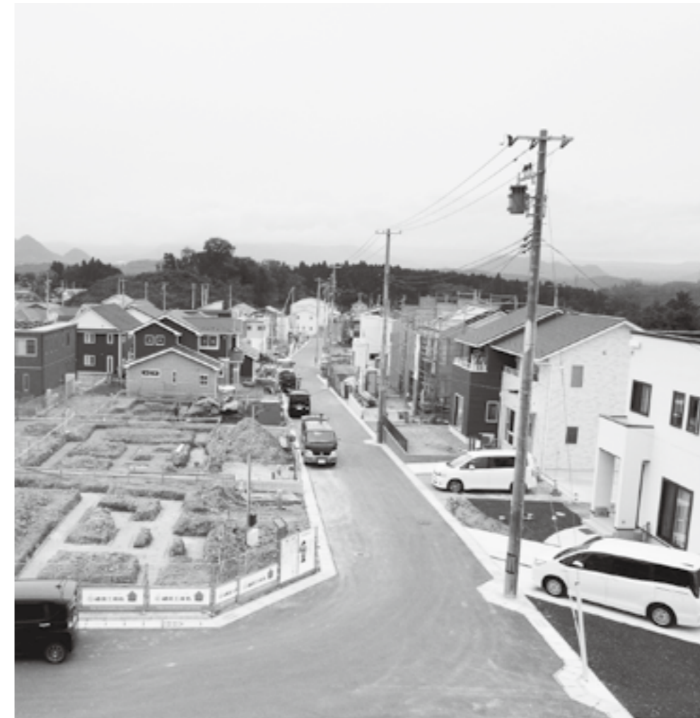
住宅建設が進むときわ台南団地
