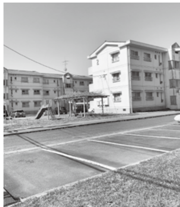
改修予定の河原住宅1・2号棟
