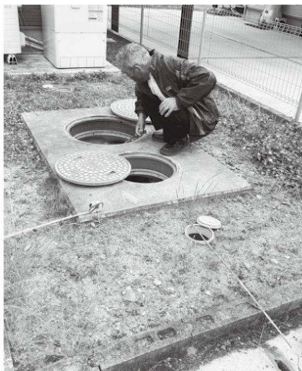
浄化槽の保守点検作業
