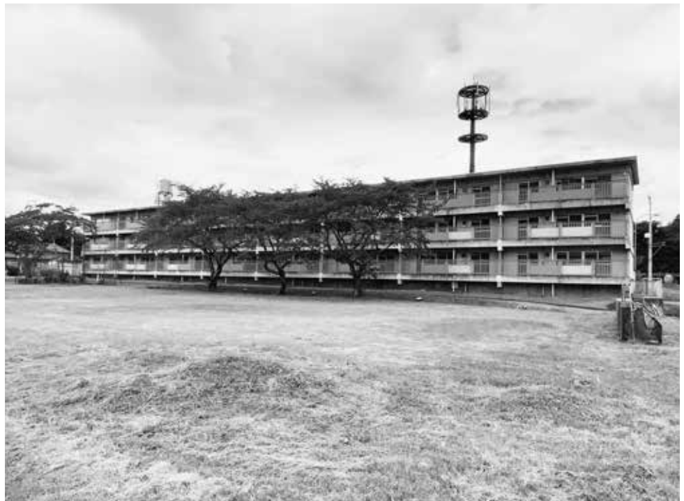
解体される五反田北住宅1号棟
