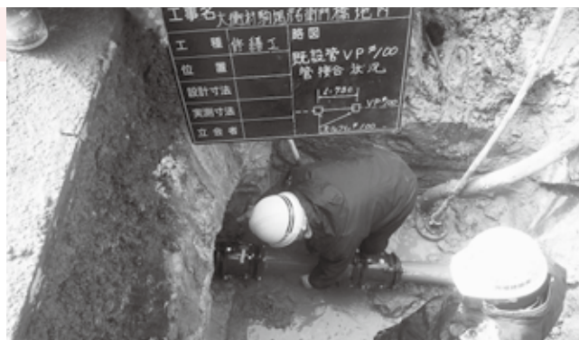
漏水箇所復旧工事
