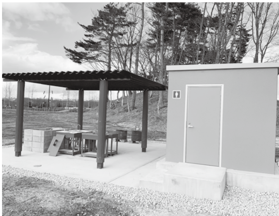
整備が完了したキャンプ場トイレ・洗い場
