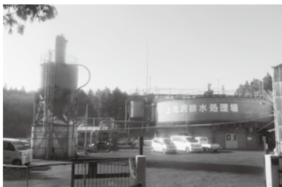
現在の処理施設
