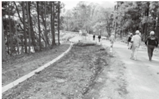
尾西2号線改良工事状況
