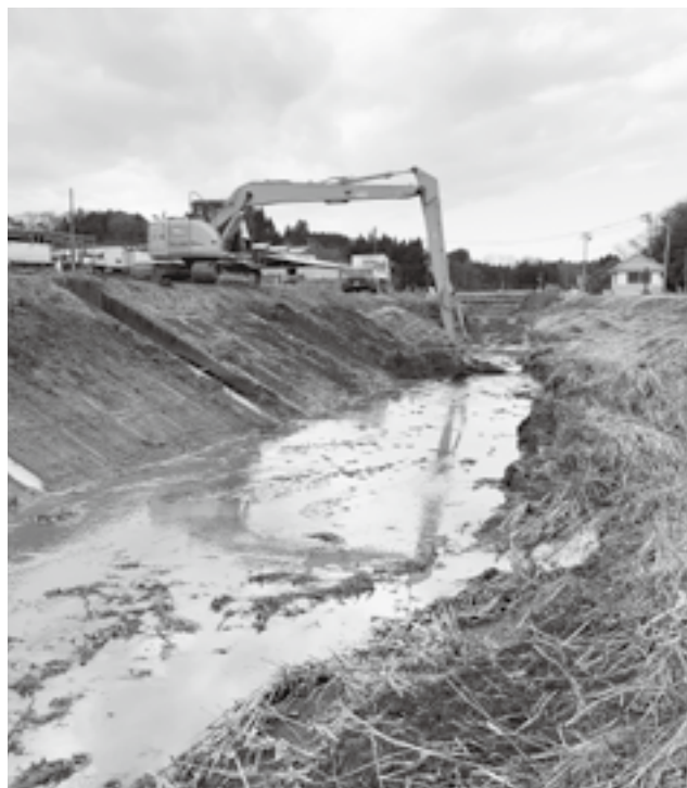
土砂の撤去が進む奥田川（羽前場堰下流）
