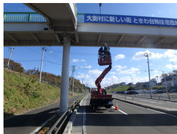
写真－2 高所作業車による点検状況
