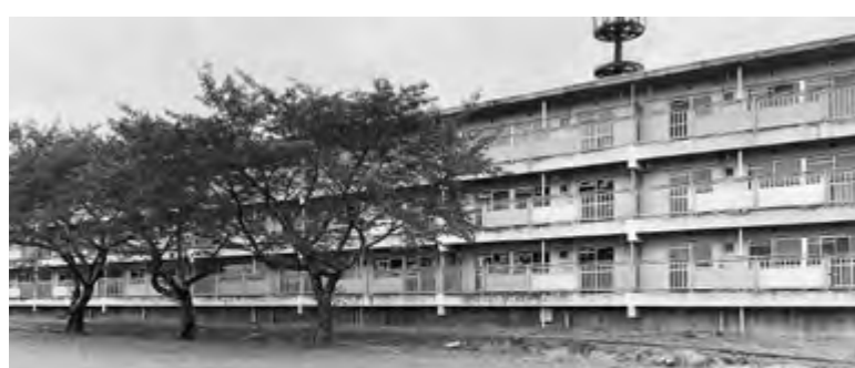
撤去予定の五反田北住宅1号棟
