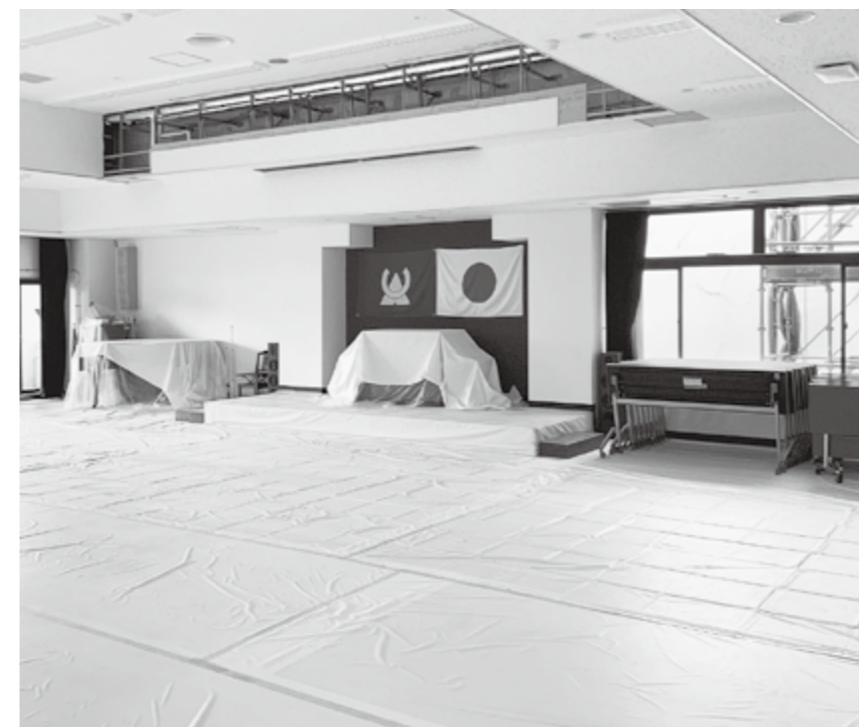
修繕工事中の平林会館
