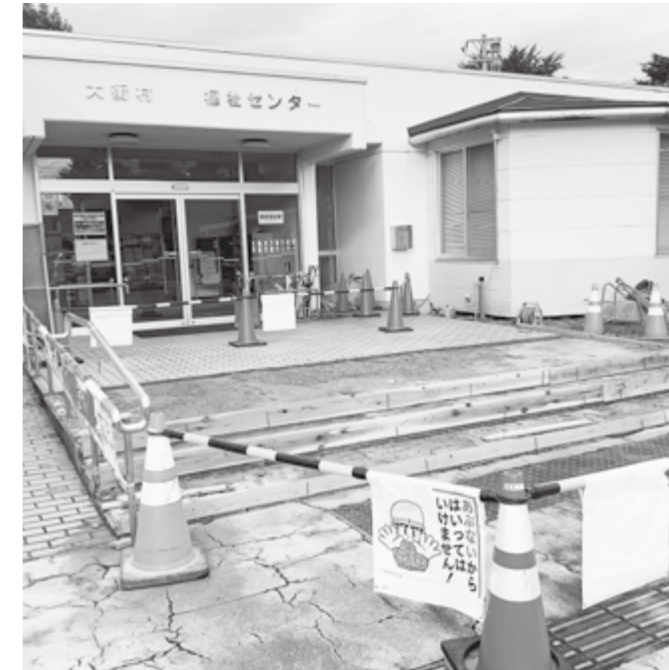
福祉センター入口修繕工事
