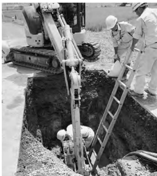
水道管漏水修繕工事
