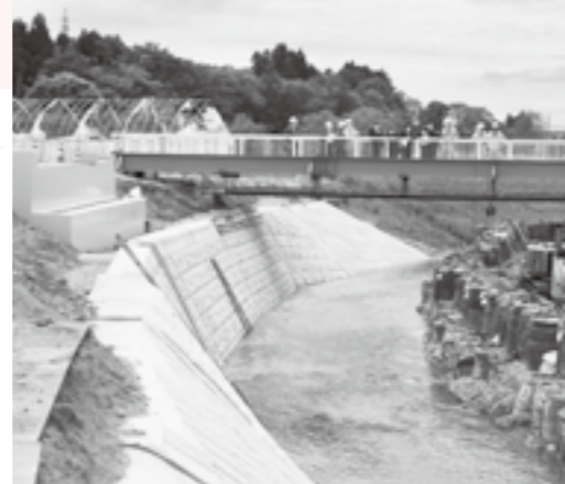
工事中の中山橋架替
