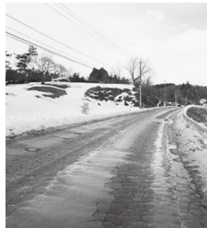
舗装補修工事予定の榎田戸口線
