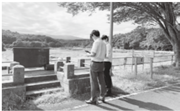
通信環境の現地調査（牛野ダム）
