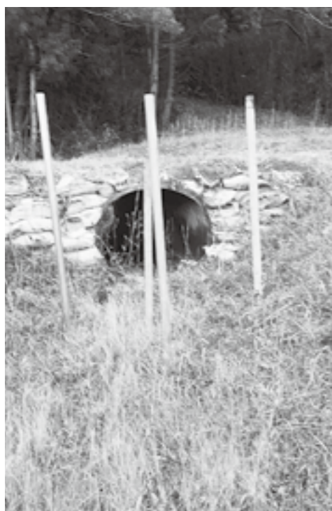
樋ノ口ため池の余水吐
