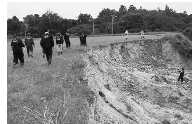
大きく崩落した農地
