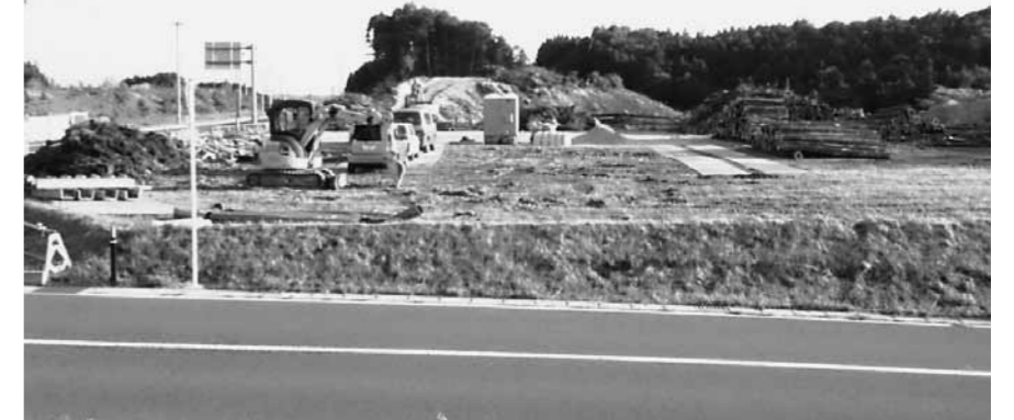
いよいよ始まった造成工事
