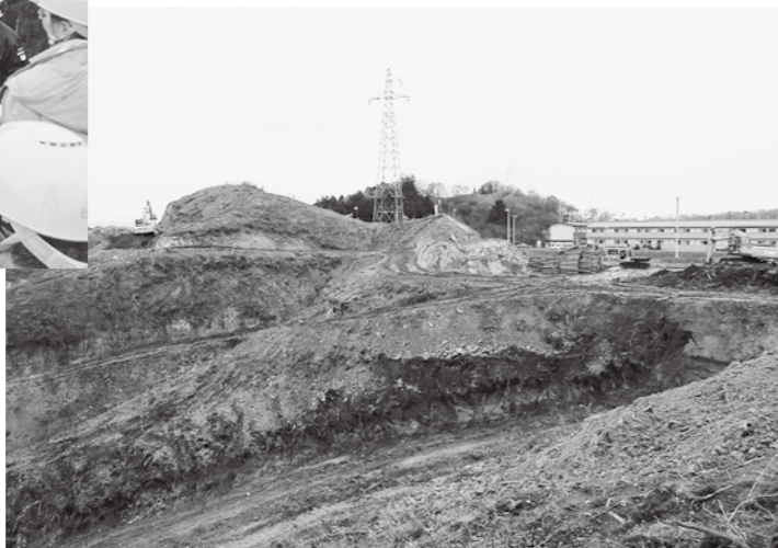
造成工事の現況
