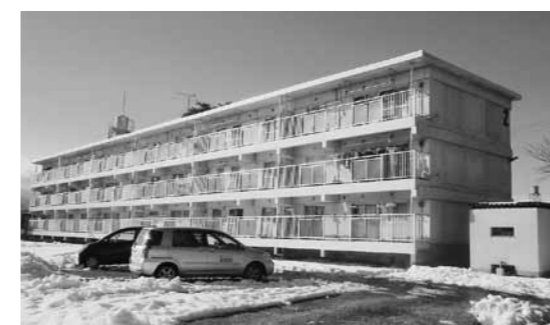
改修が待たれる村営住宅
