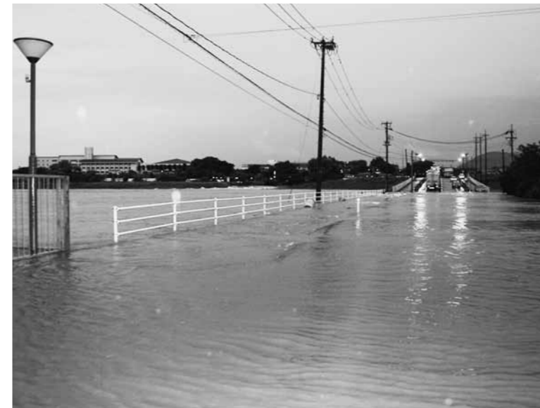
通行止めになった県道大衡駒場線
