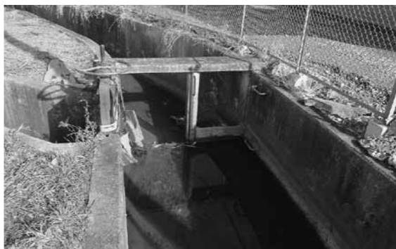
海老沢地区板堰
