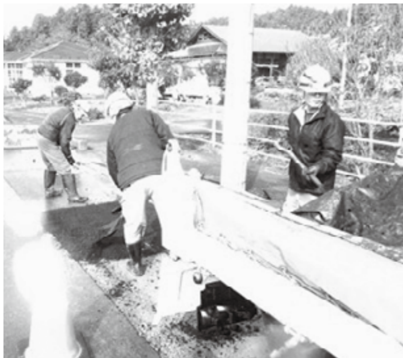
下水管の修理工事（衡下地区）
