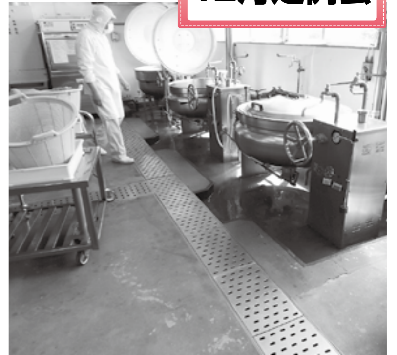
ウェット方式の現給食センター
