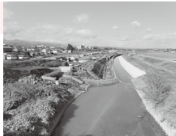
築堤工が進められている善川
