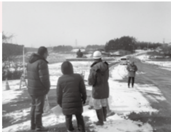
委員が下見する舗装工事現場
