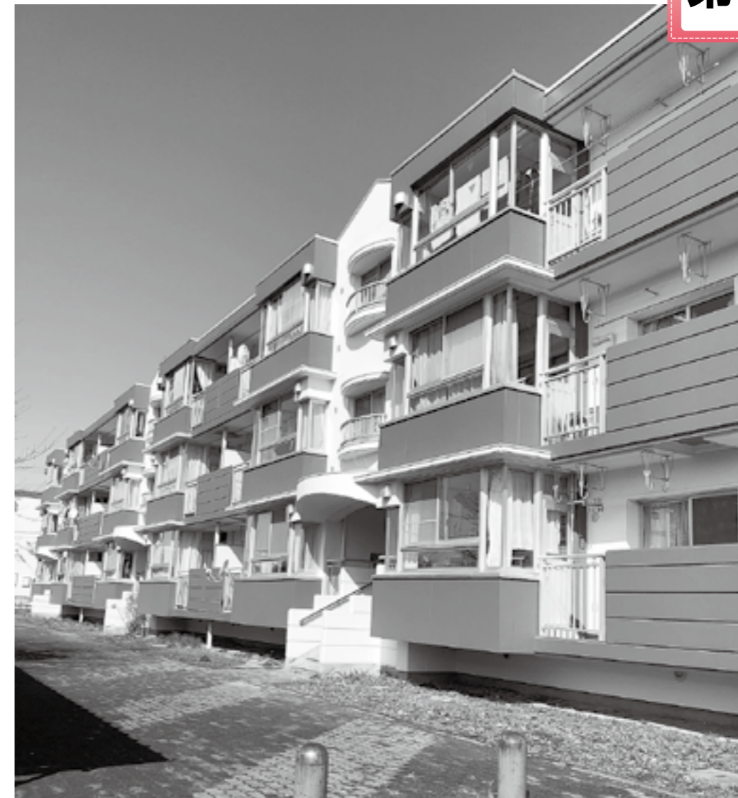
改修された五反田住宅
