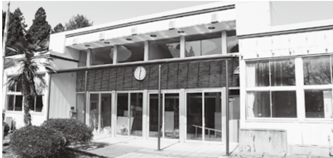
活用案が決まっていない旧幼稚園舎
