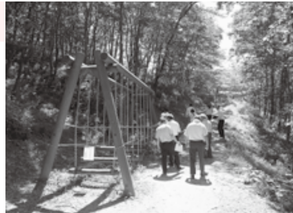
老朽化が進む遊具
