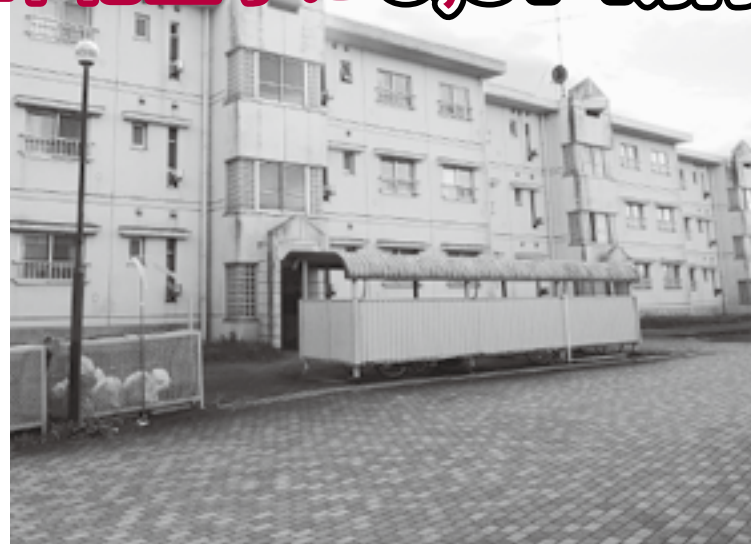
今回工事予定の河原住宅3号棟
