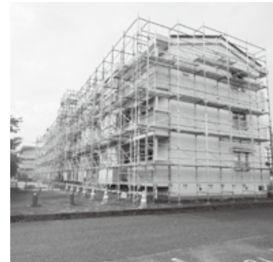
村営住宅改修
