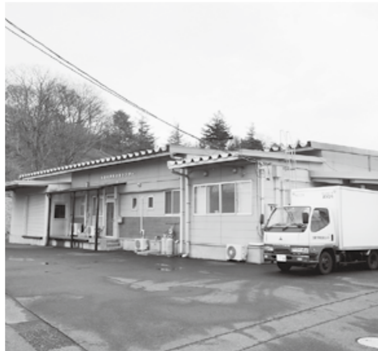
建て替え予定の給食センター
