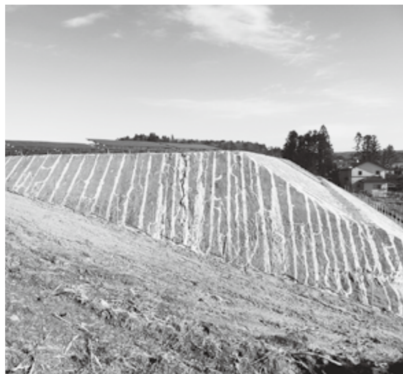
太陽光発電施設の法面（大森）
