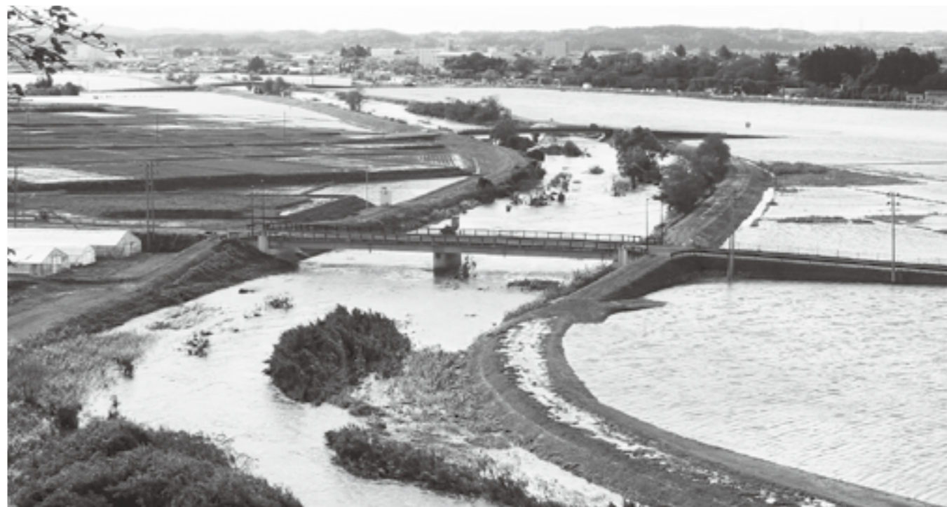
大雨で冠水被害にあった善川流域（衡下）
