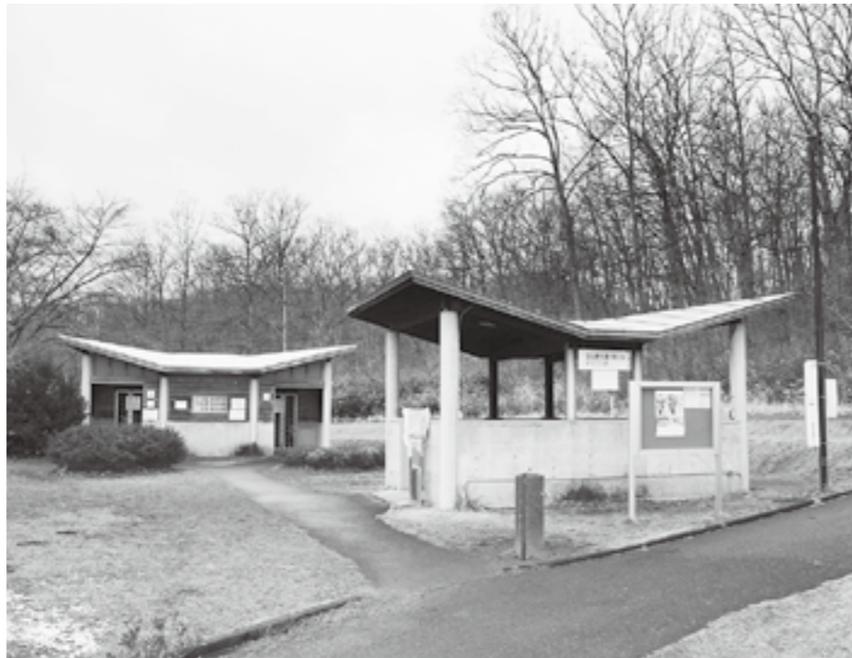
牛野ダムキャンプ場のトイレ・炊事場
