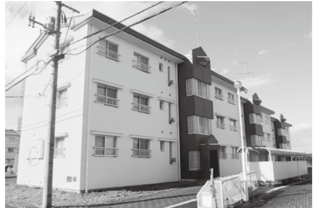
改修された河原住宅3号棟
