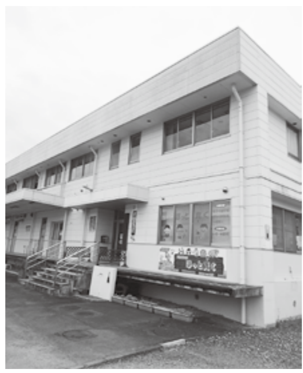
けやき教室が入る富谷市複合公共施設・けやき館
