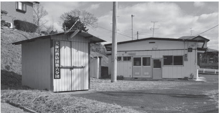
▲第6分団消防ポンプ小屋（奥田地区）
