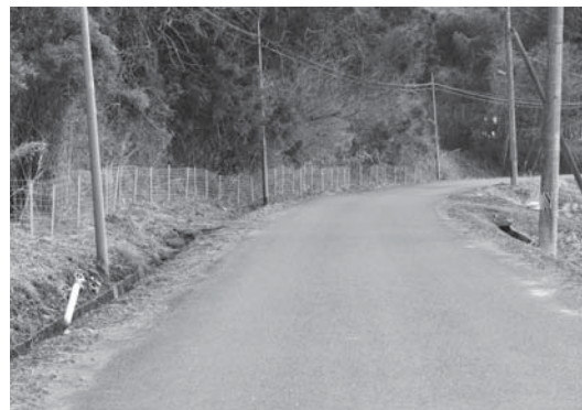
▲大瓜下地区に設置されたワイヤーメッシュ柵
