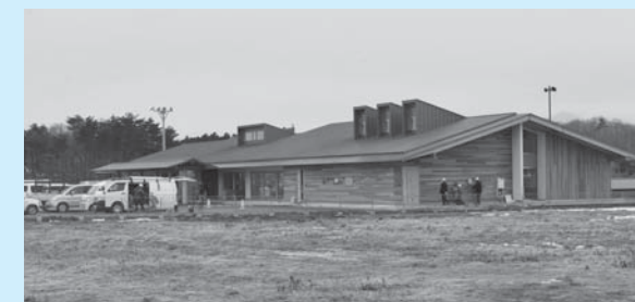
▲開所に向けて工事が進む「わ・は・わ大衡」
