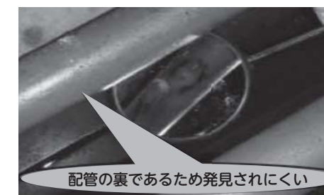
劣化した配管から油流出
