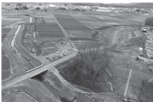
▲整備が進む善川遊水地
