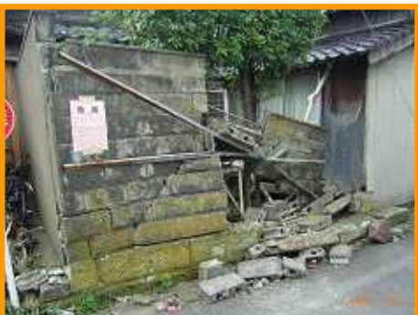
地震により倒壊したブロック塀などの例
