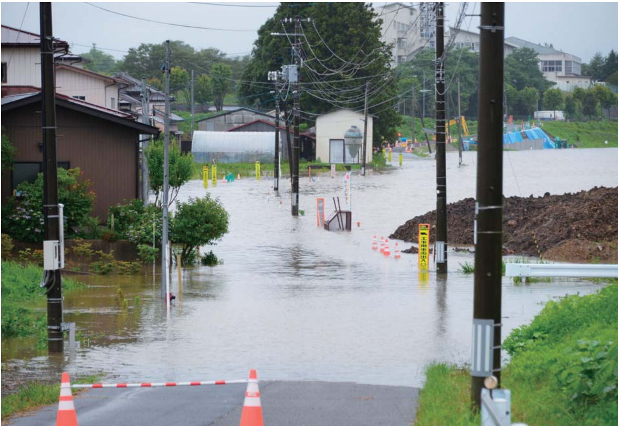
▲衡下地区海老沢地内道路の冠水状況
