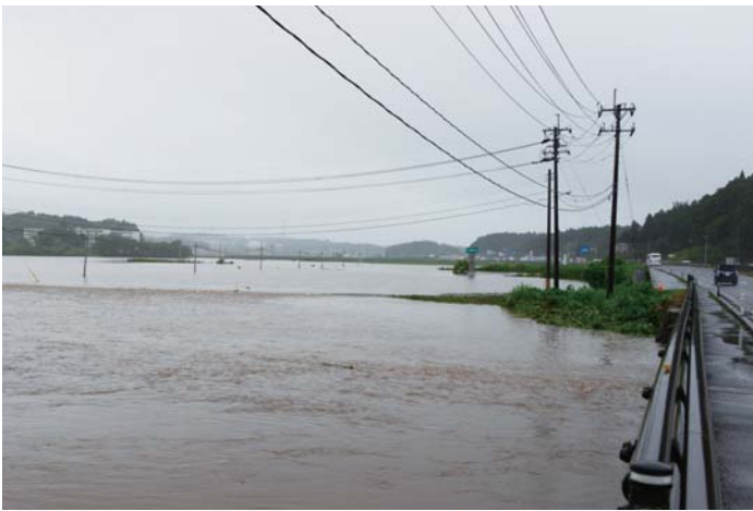
▲衡中地区野畑、大童地内の冠水状況
