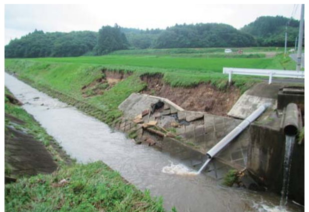
▲駒場地区阿園橋付近
