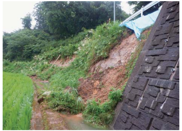
▲大森地区村道湯の沢線法面崩落
