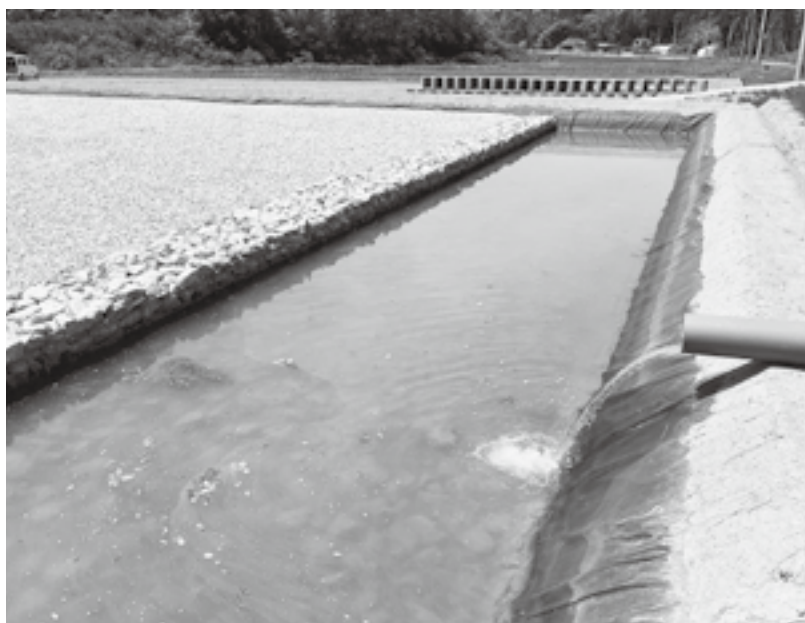
新たな水処理プラント（上北沢排水処理場）
