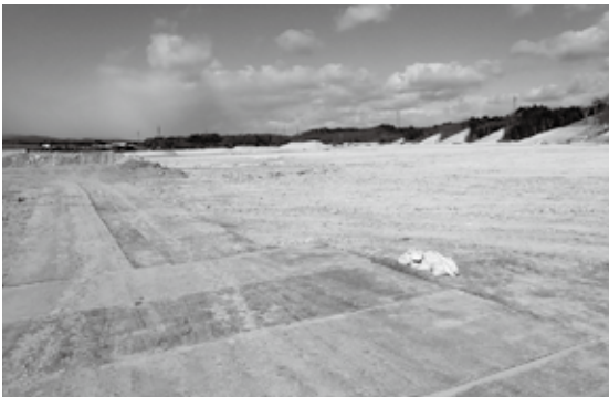
造成中の工業団地
