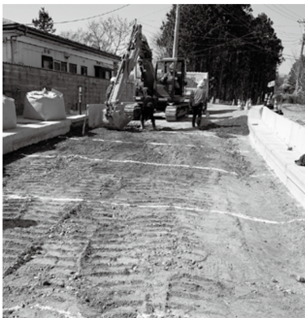
翌年度へ繰越す尾西2号線工事
