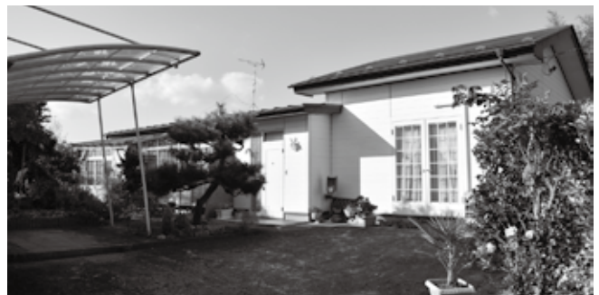
有効活用が望まれる空き家
